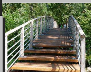
Le 31/7, passerelle rénovée
