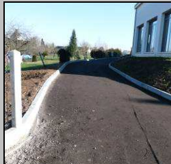
Travaux à l'école
