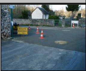
Travaux rue de Stalingrad
