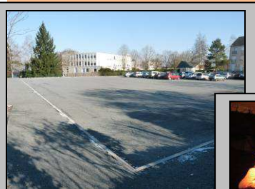
Le 30, parking terminé
